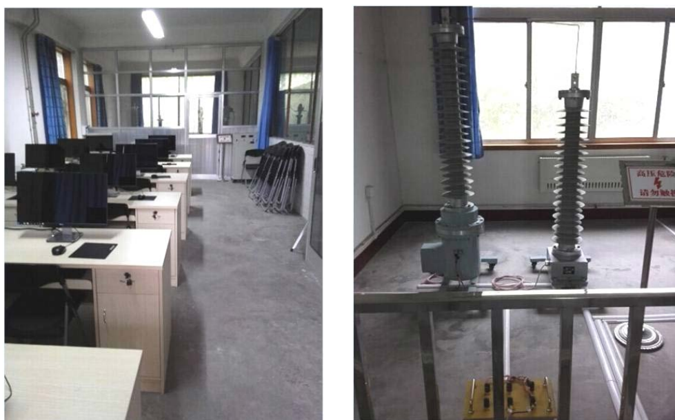
图 16 高压电气测量实训室
